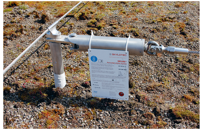
Fig. 24: Marquage d'installation spécifique à l'ouvrage
