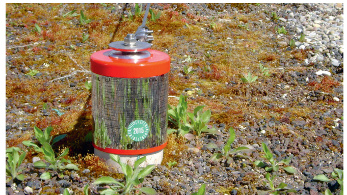
Fig. 25: Marquage d'installation spécifique à l'ouvrage avec vignette de contrôle
