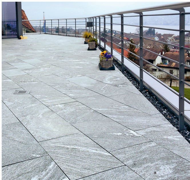
Fig. 18: Classe d'équipement 4 pour des surfaces de toit accessibles en public
