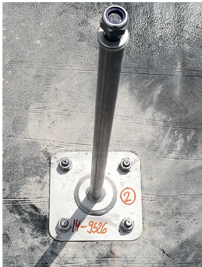
Fig. 23: Le point de fixation monté et marqué pour la photo de procès-verbal avec l'année, le numéro d'ouvrage du fabricant et d'un numérotage continu
