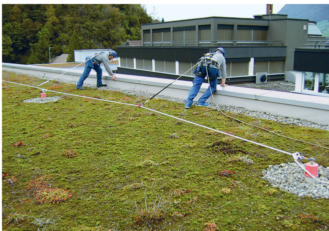
Fig. 10 Système à câble temporaire avec mousqueton fixé au PAI
